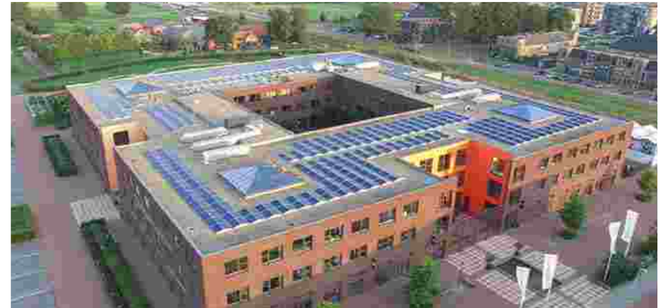
Nederland (303 kW) School De Meerwaarde, Barneveld
