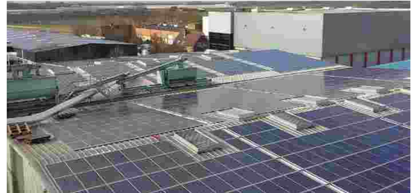
Nederland (2,4 MW) Plospan Waardenburg, houtverwerking
